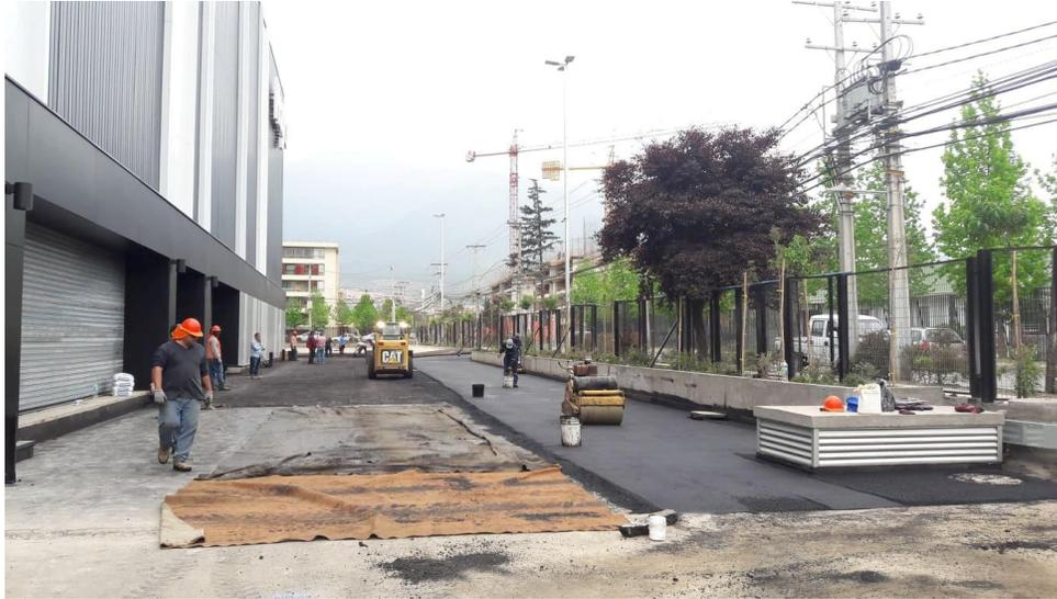
Ilustración 13. Instalación de Asfalto
