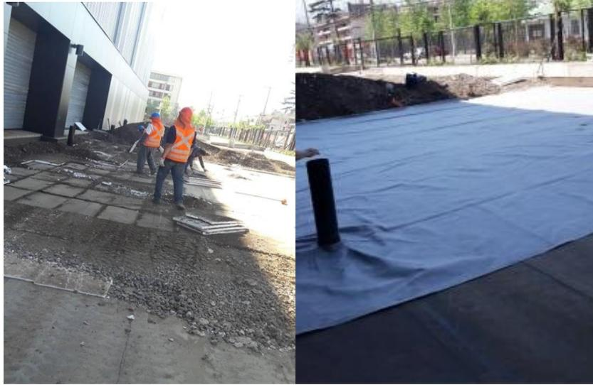
Ilustración 23. Retiro de Plumavit e Instalación de Geotextil
