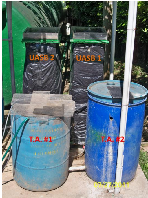
Figura 13. Sistema configurado para la ejecución del tratamiento
