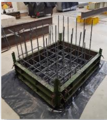
Figurado y modulación de la base del muro.
