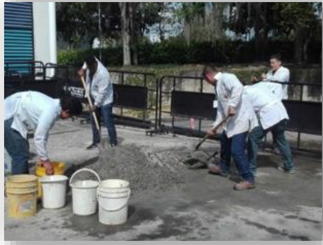
Preparación de mezcla
