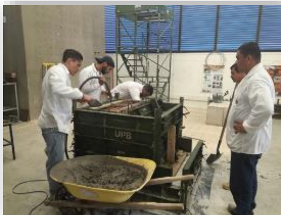
Fundida de la espalda del muro
