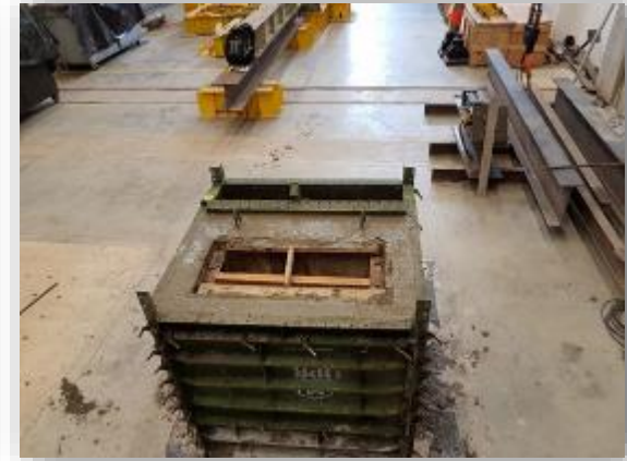
Fundida de la espalda del muro
