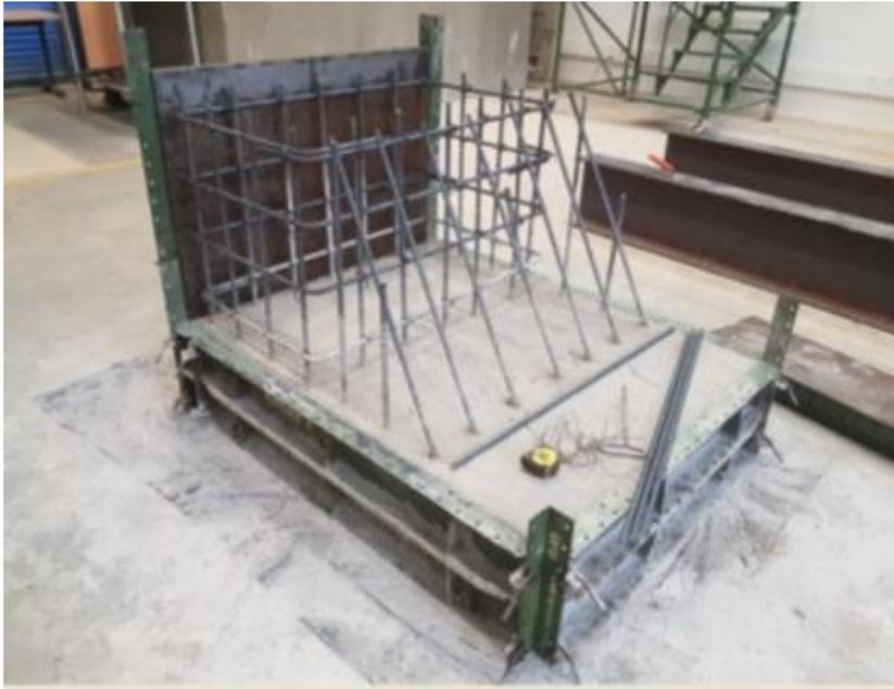
**Figura 18.** Encofrado y fundida de la base talón - punta.
