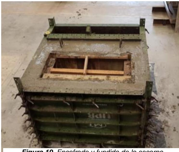
**Figura 19.** Encofrado y fundida de la escarpa.
