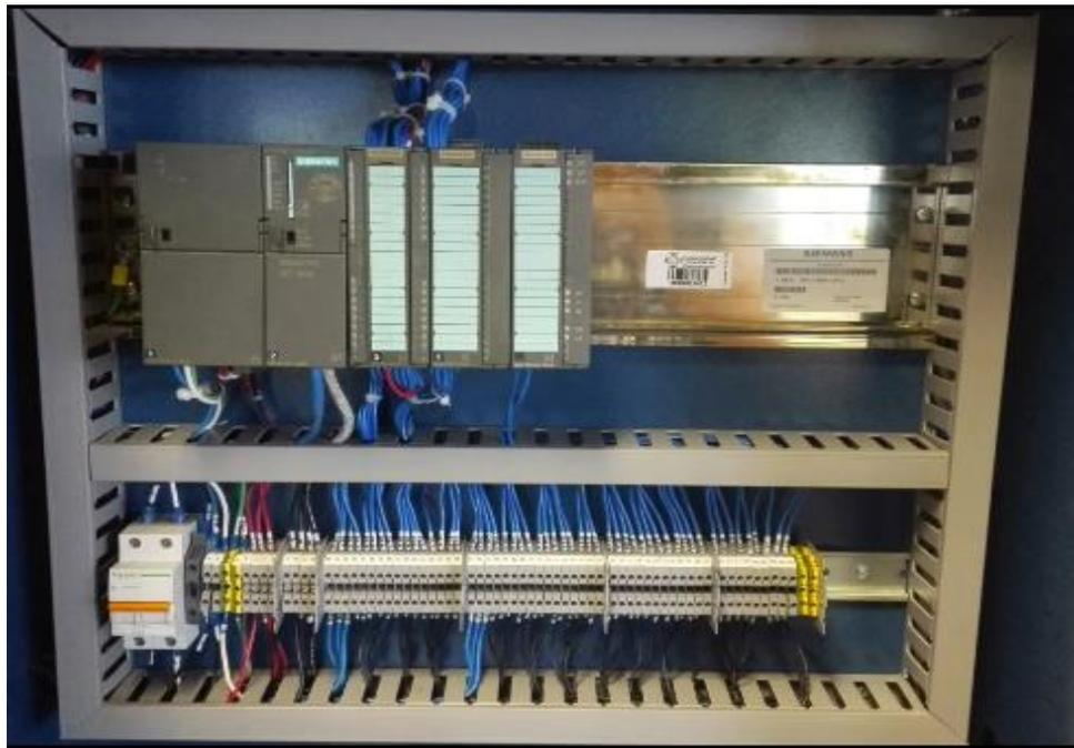
**Figura 2.** Módulos del *PLC S7-300*. **Fuente:** Autor.
