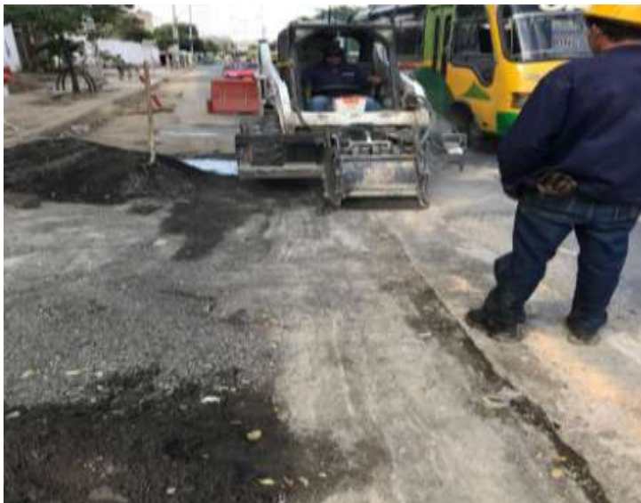
Imagen 14. Fresado de pavimento con minicargador
