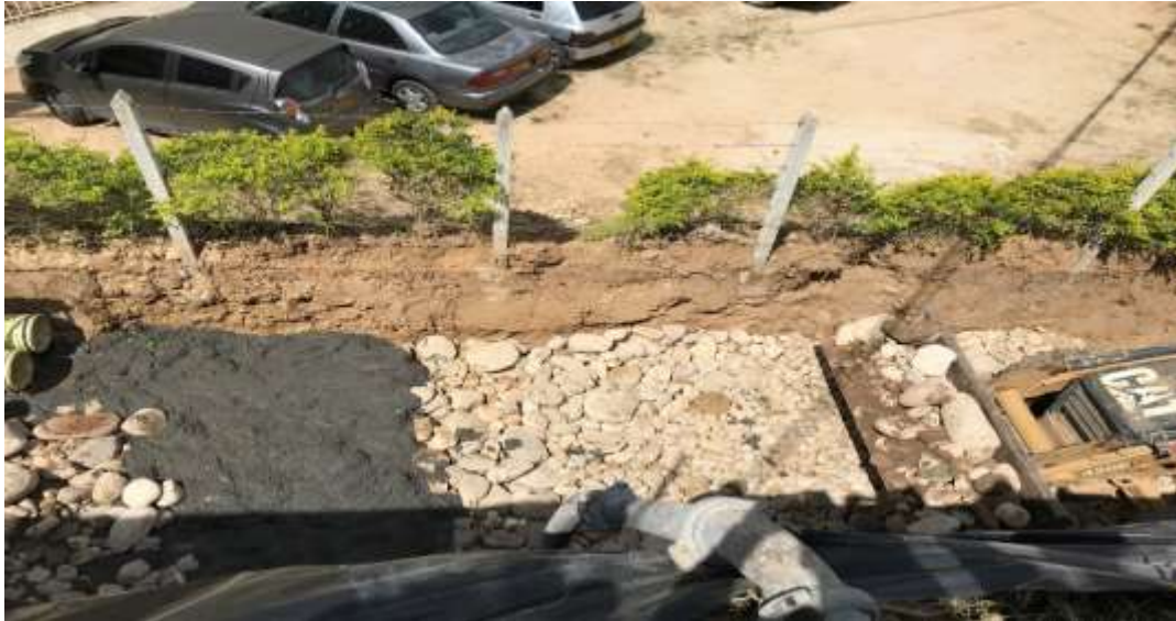
Imagen 29. Vaciado de concreto en la piedra ciclópea
