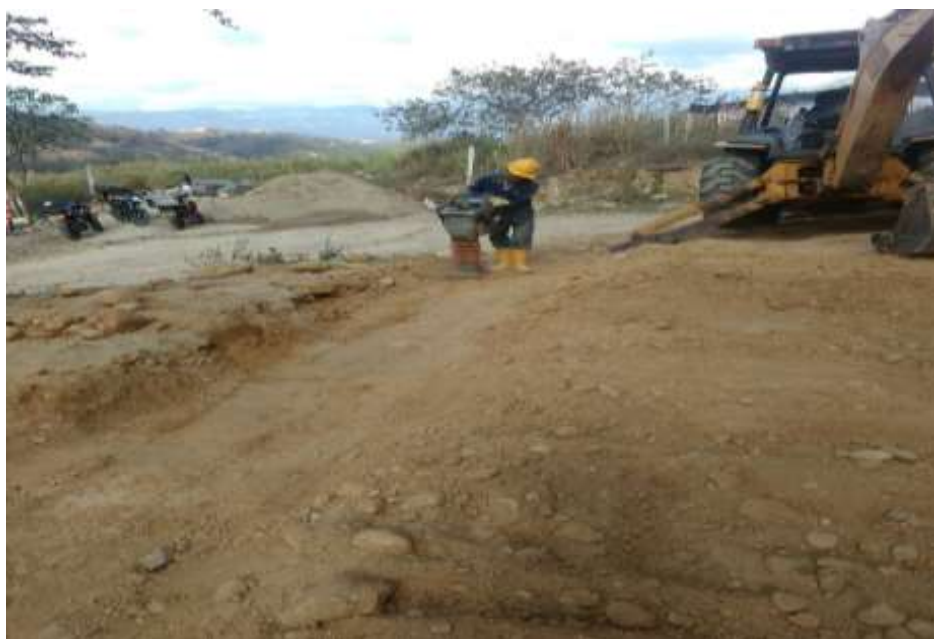
Imagen 42. Compactación del relleno con apisonador
