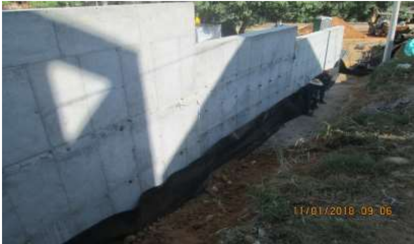
Imagen 31. Muro en forma escalonada
