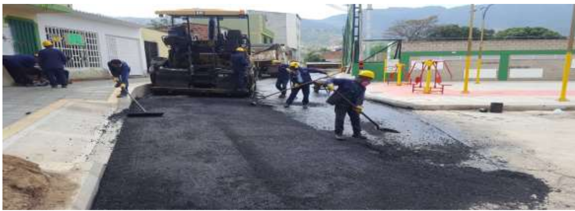
Imagen 10a. Aplicación MDC-19 mediante Finisher Caterpillar.
