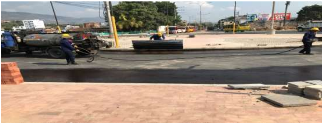
Imagen 21a. Aplicación de emulsión rotonda interna
