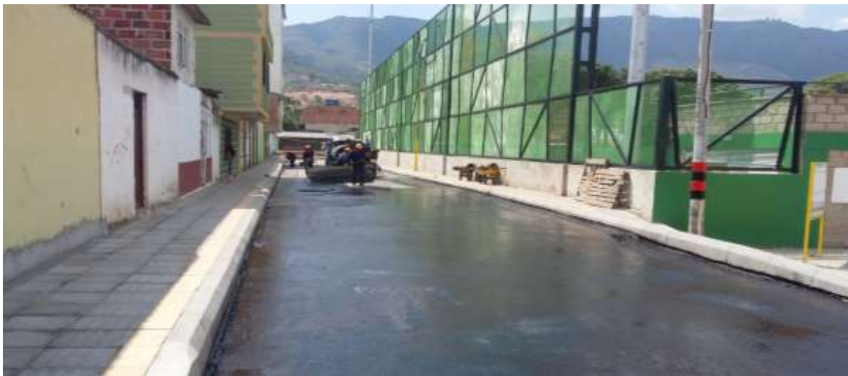
Imagen 8. Aplicación emulsión asfáltica
