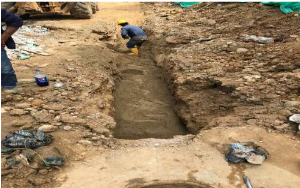
Imagen 38. Recubrimiento de tubería con arena gruesa
