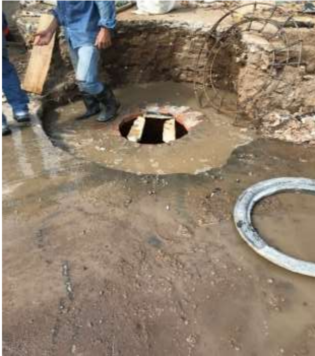
Imagen 6. Construcción del pozo sector Primero de Mayo
