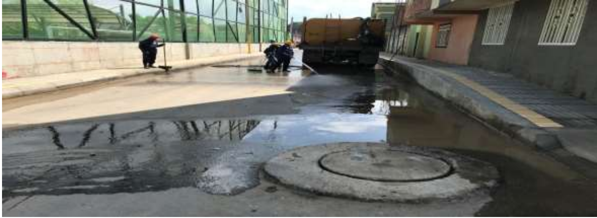
Imagen 7. Lavado previo a la imprimación
