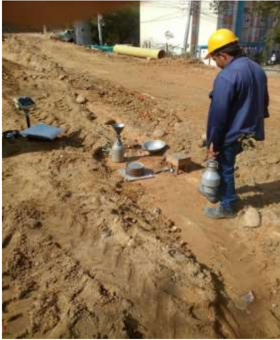
Imagen 45. Toma de ensayos de densidades al relleno
