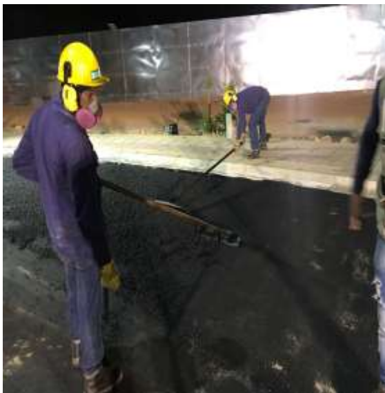
Imagen 23d . Extensión de la mezcla
