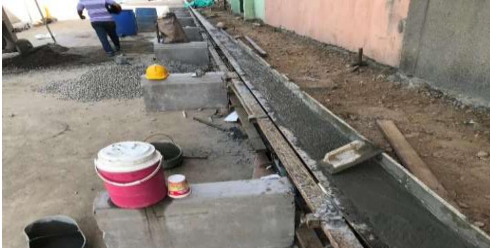
Imagen 4. Muro de contención ABS K0+030 – k0+068m
