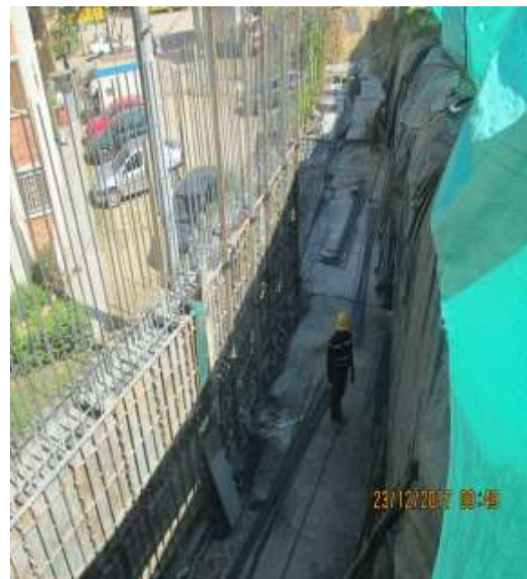
Imagen 34b. Vaciado de concreto cuerpo 2 K0+085m - k0+095 m
