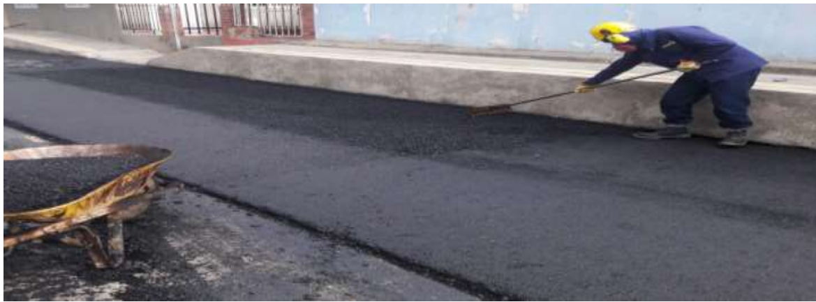
Imagen 10b. Extensión de la mezcla por jefe de la cuadrilla
