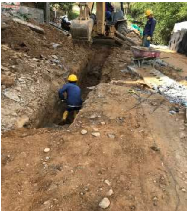
Imagen 36. Excavación del pozo en la ABS k0+0.95m
