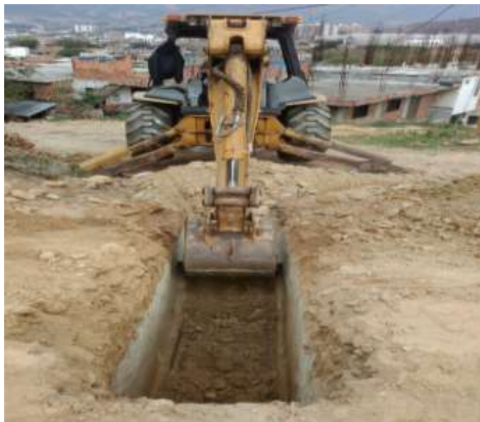
Imagen 40. Excavación del terreno k0+200 P(AL)L1 - P(AL)L2
