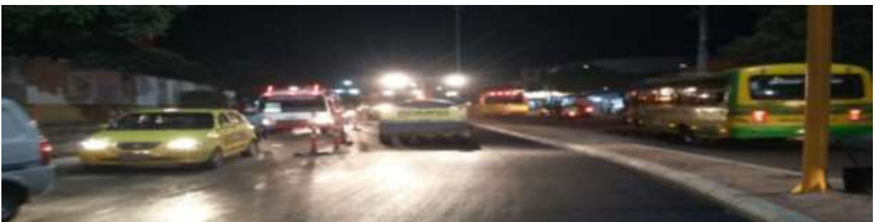
Imagen 27c. Simulación de tráfico mediante el compactador de llantas
