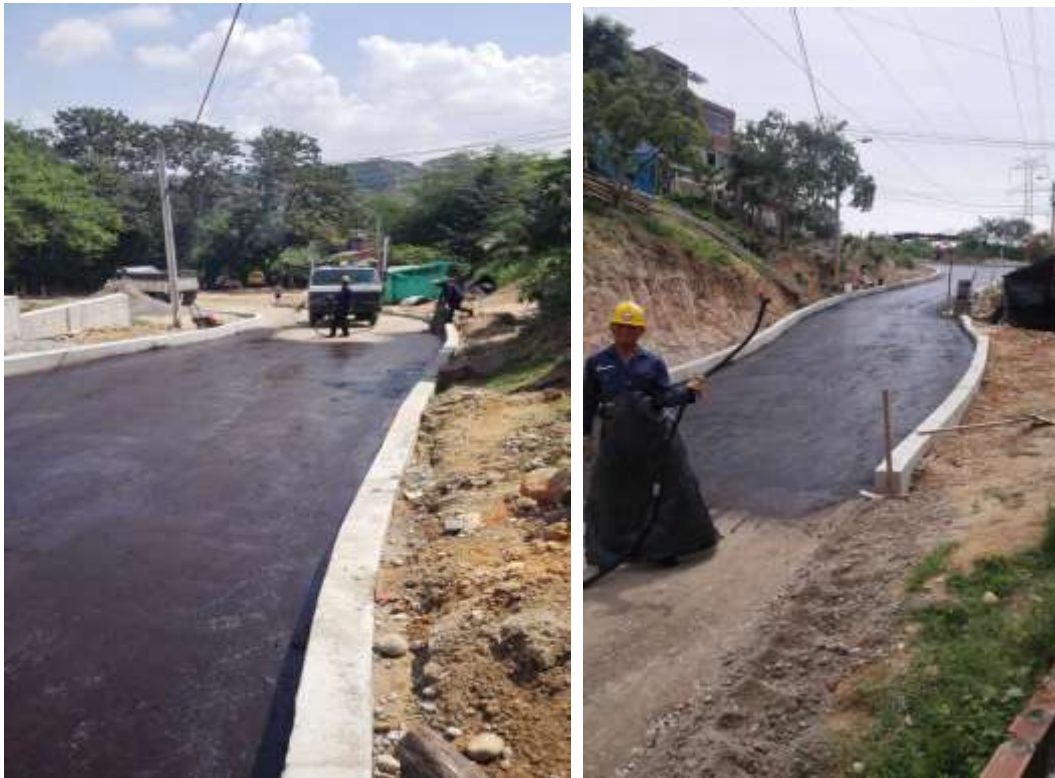
Imagen 51a. Aplicación de emulsión con irrigador
