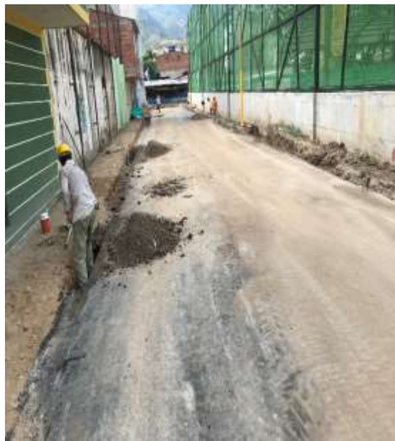
Imagen 2a. Excavación manual borde Derecho
