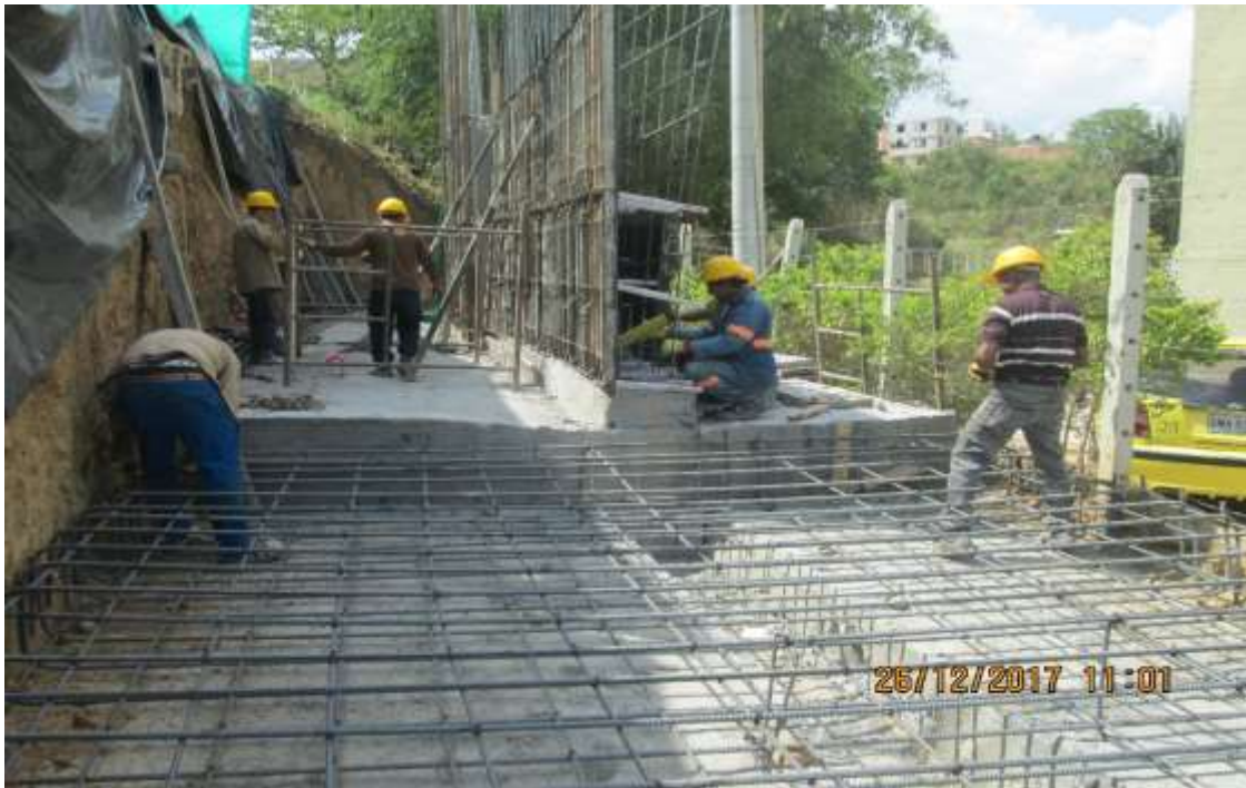
Imagen 33. Amarren y figurado de acero.
