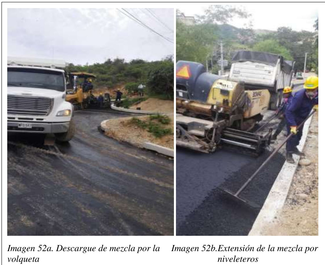
Imagen 52. Descargue y aplicación de mezcla asfáltica
