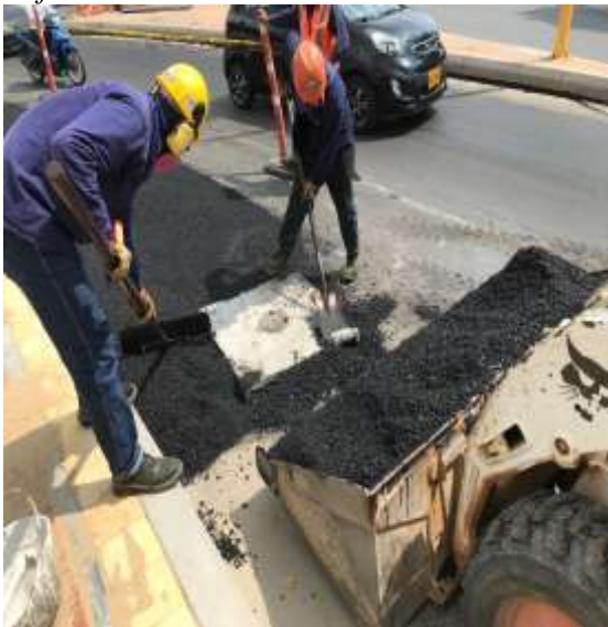
Imagen 23c . Aplicación de mezcla en caja por mini cargador
