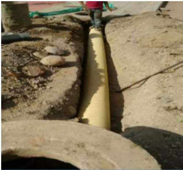
Imagen 5. Instalación tubo PVC 10 k0+110m, sector Primero de Mayo
