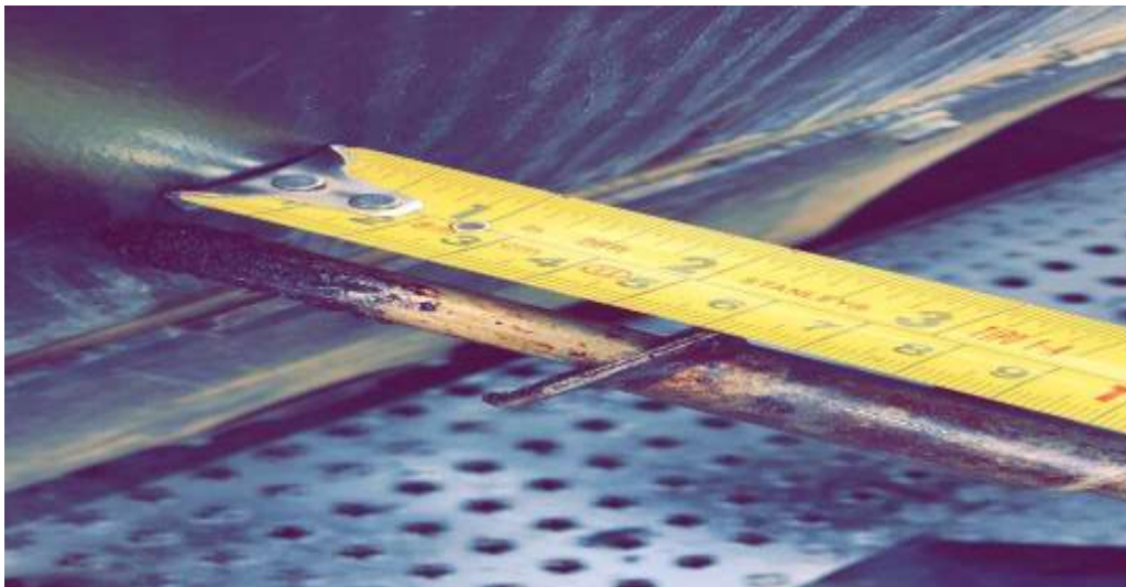
Imagen 22. Espesor de la carpeta de rodadura
