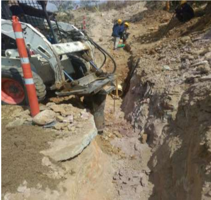
Imagen 43. Demolición de rocas con mini cargador
