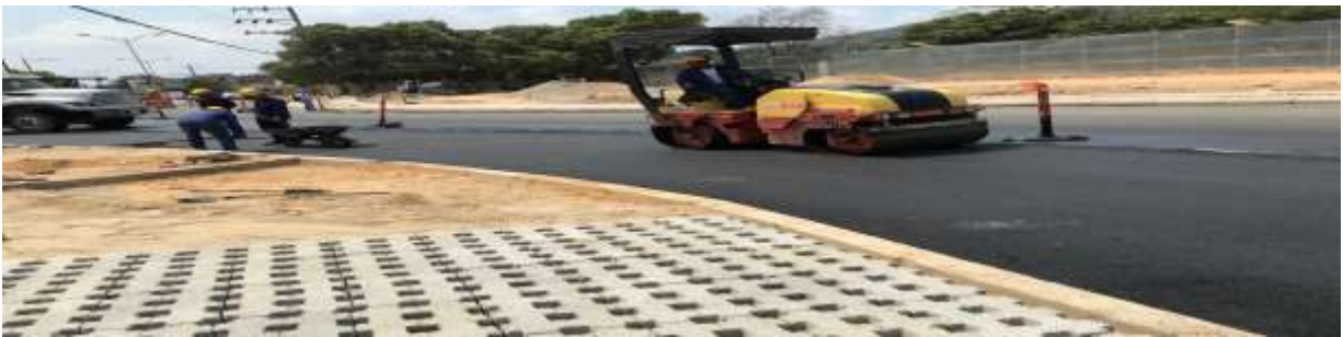
Imagen 27b. Compactación rotonda interna
