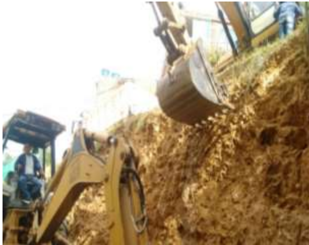
Imagen 31a. Excavación para la construcción del muro
