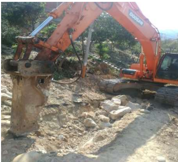
Imagen 44. Demolición de rocas con retroexcavadora
