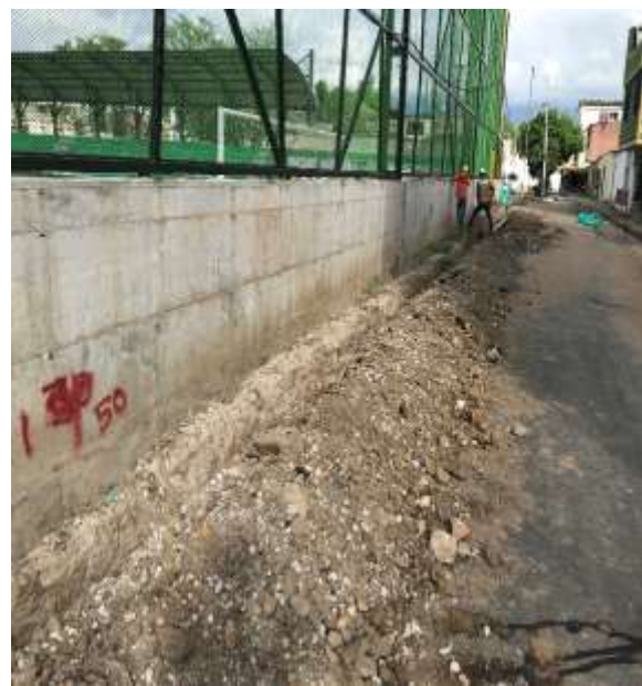
Imagen 2b. Demolición andén existente
