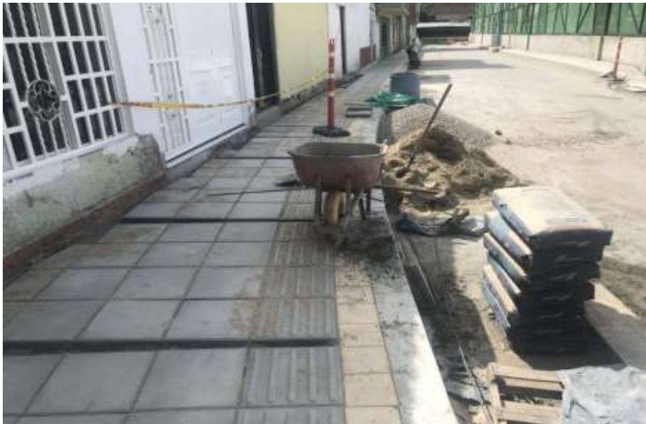
Imagen 3. Instalación loseta prefabricada
