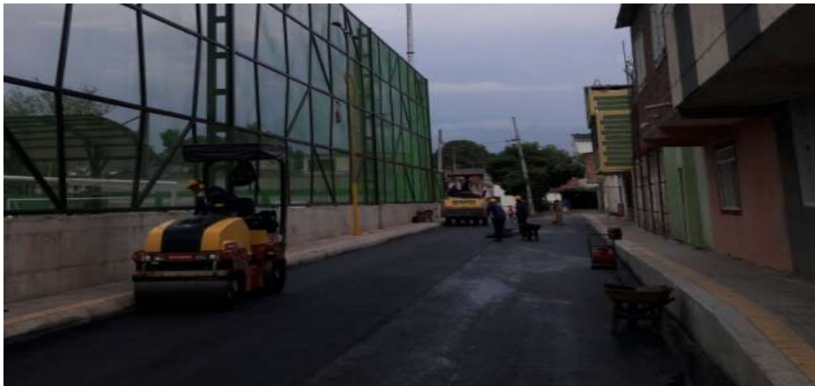
Imagen 10c. Compactación de la mezcla
