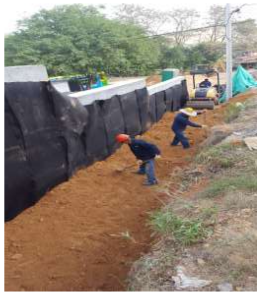
Imagen 35b. Extendido de relleno
