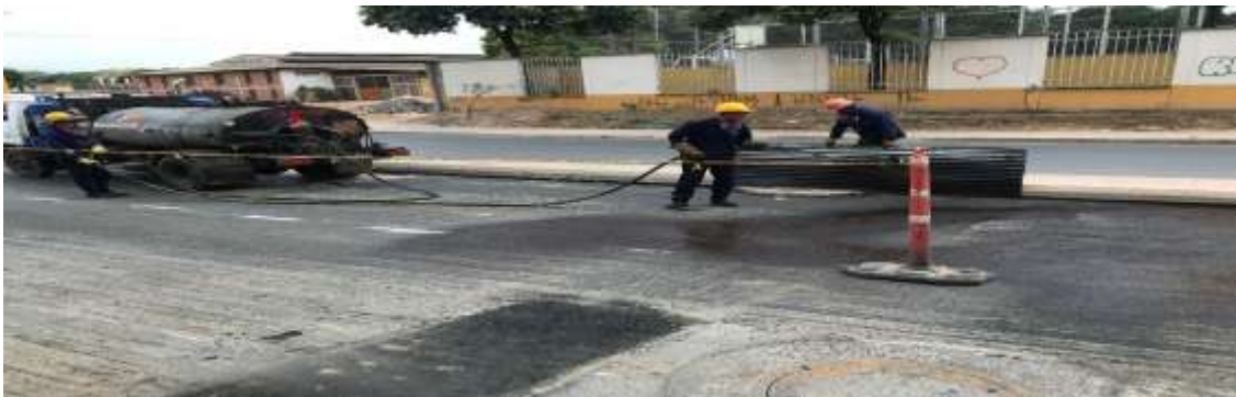
Imagen 21b. Emulsión asfáltica eje 4 Rotonda
