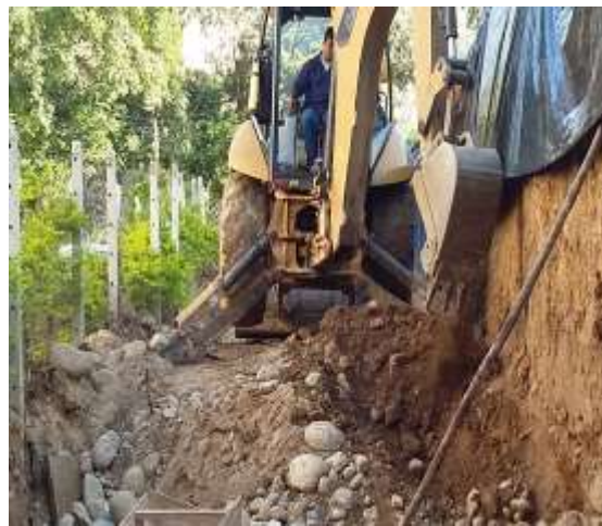
Imagen 31b. Excavación ABS k0+070m
