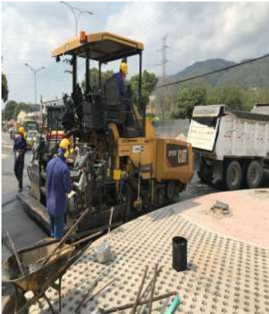
Imagen 23a. Aplicación de la mezcla con la finisher
