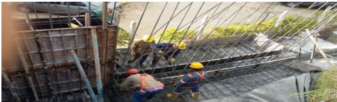
Imagen 34c. Vibración manual en la zapata
