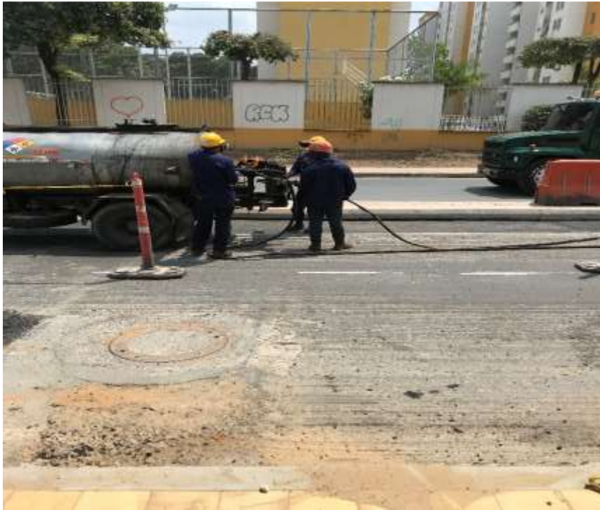
Imagen 18. Calentamiento de la manguera del irrigador
