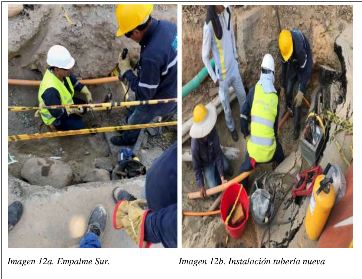
Imagen 12. Empalmes de la tubería de gas existente con la tubería nueva.
