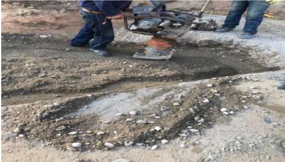
Imagen 13. Relleno de los empalmes con base granular y compactadas con apisonador
