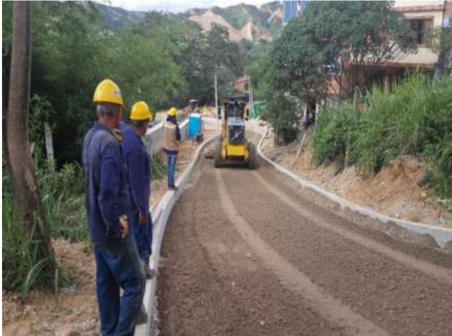
Imagen 49. Conformación de la base por motoniveladora
