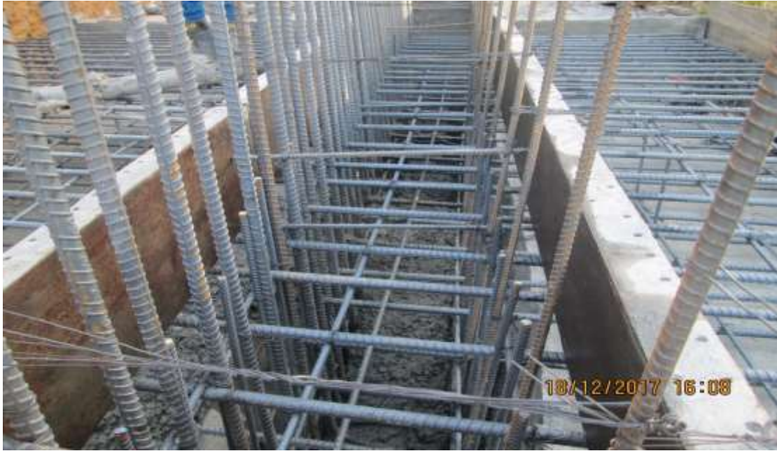
Imagen 32. Acero de refuerzo ½" dentellón
