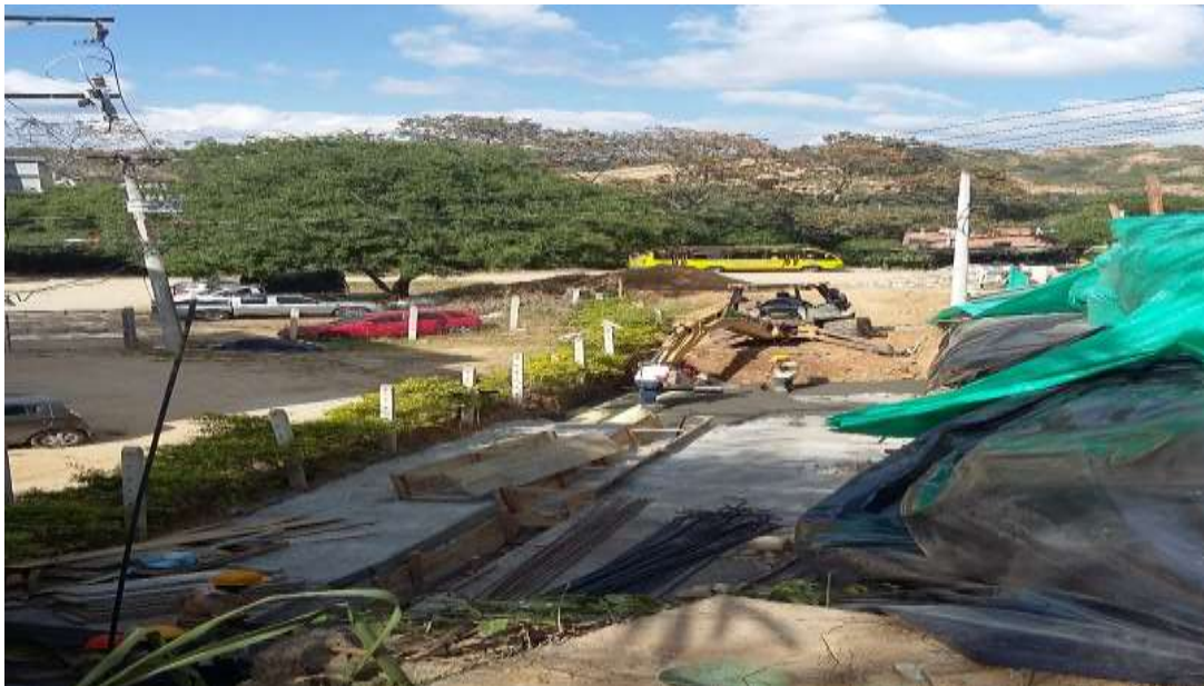
Imagen 30. Construcción del dentellón
