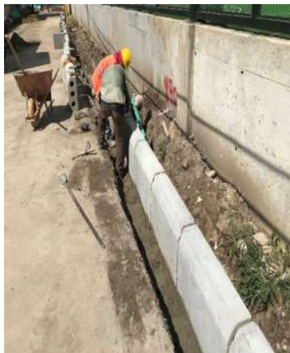
2.d Instalación Sardinel ABS k0+090m
