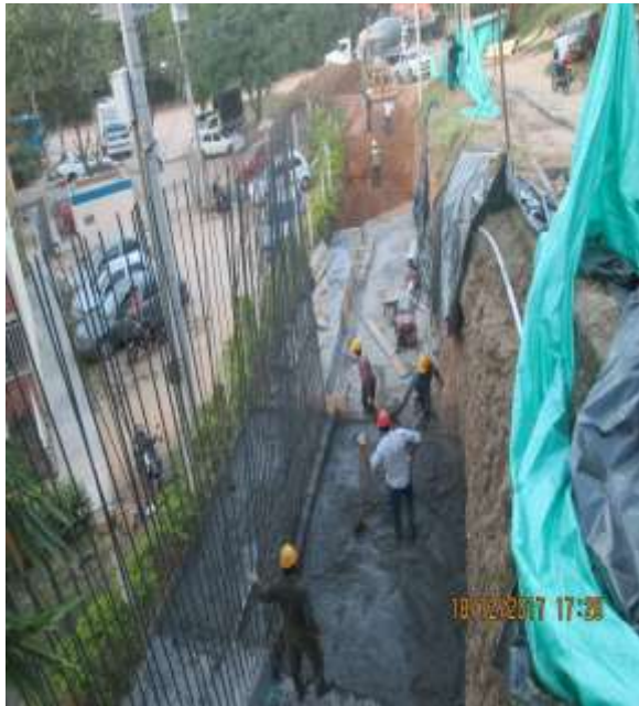
Imagen 34a. Vaciado de concreto en zapata
