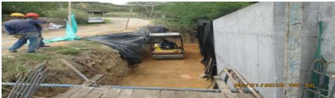
Imagen 35c. Compactación de relleno
