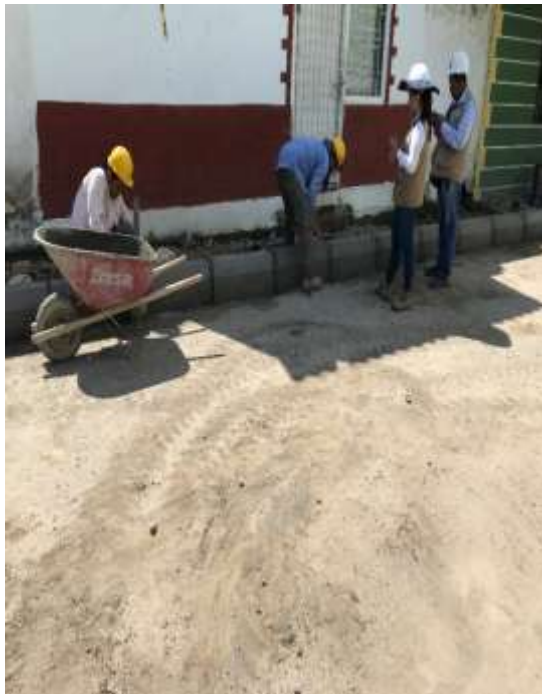
Imagen 2c. Instalación Sardinel borde derecho Imagen
