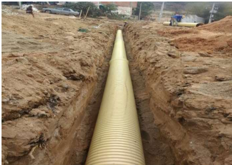
Imagen 41. Instalación de tubería P(AL) L8 - P(AL) L9
