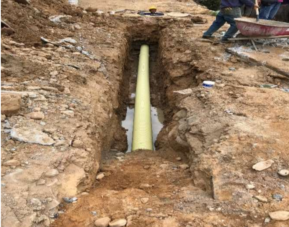
Imagen 37. Instalación de tubería
