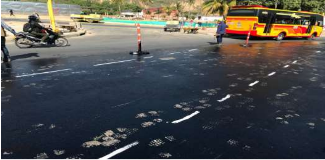
Imagen 20. Señalización del carril a pavimentar.
