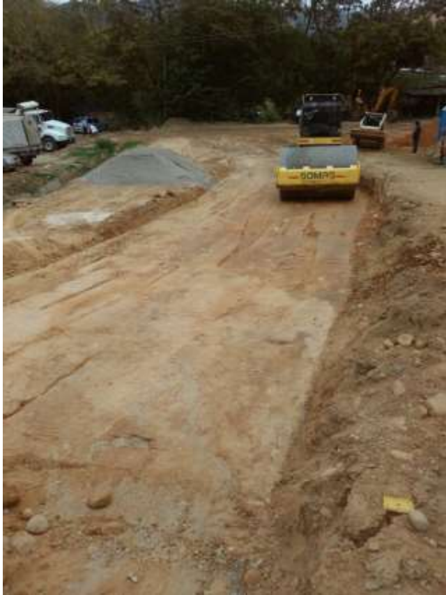
Imagen 48. Compactación Subrasante k0+032m
