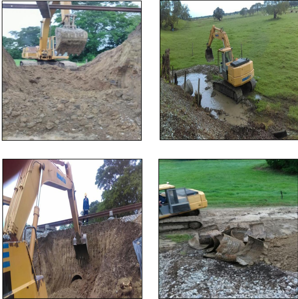
Figura 6. Inicio de obra- Rehabilitación del punto crítico PK 233+568
