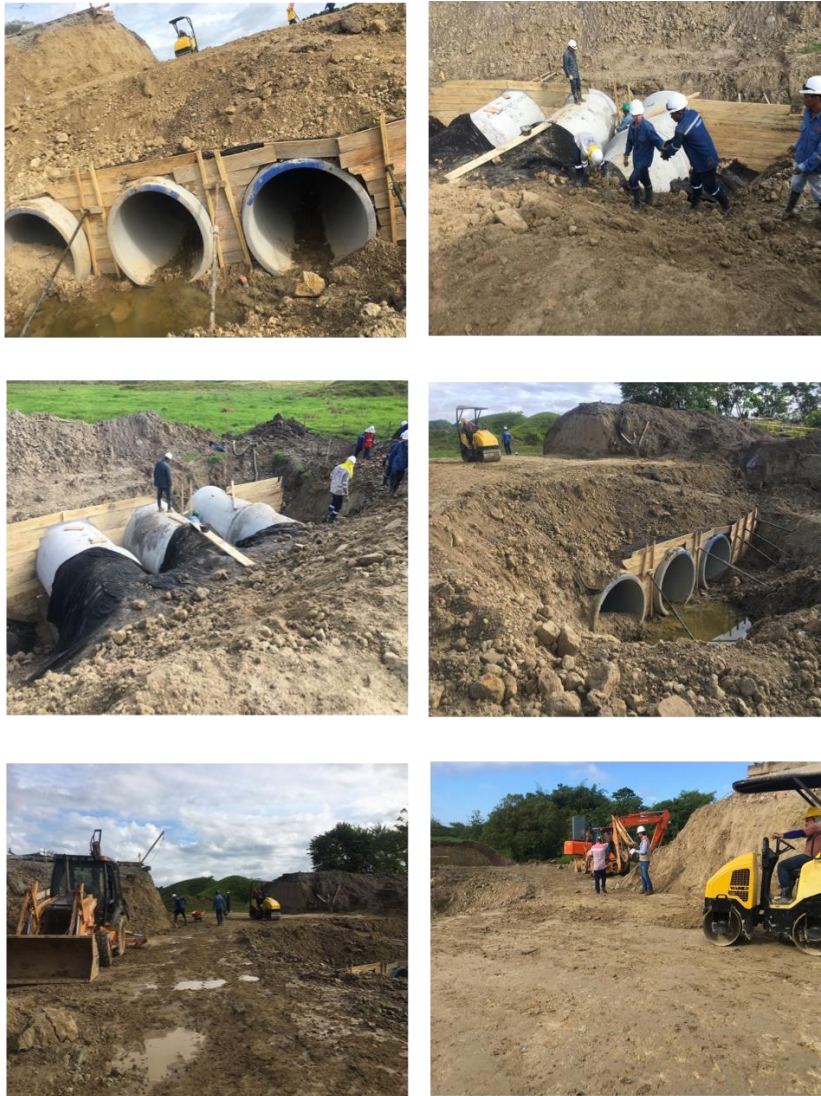
Figura 12. Alcantarilla ubicada en PK 358+100
