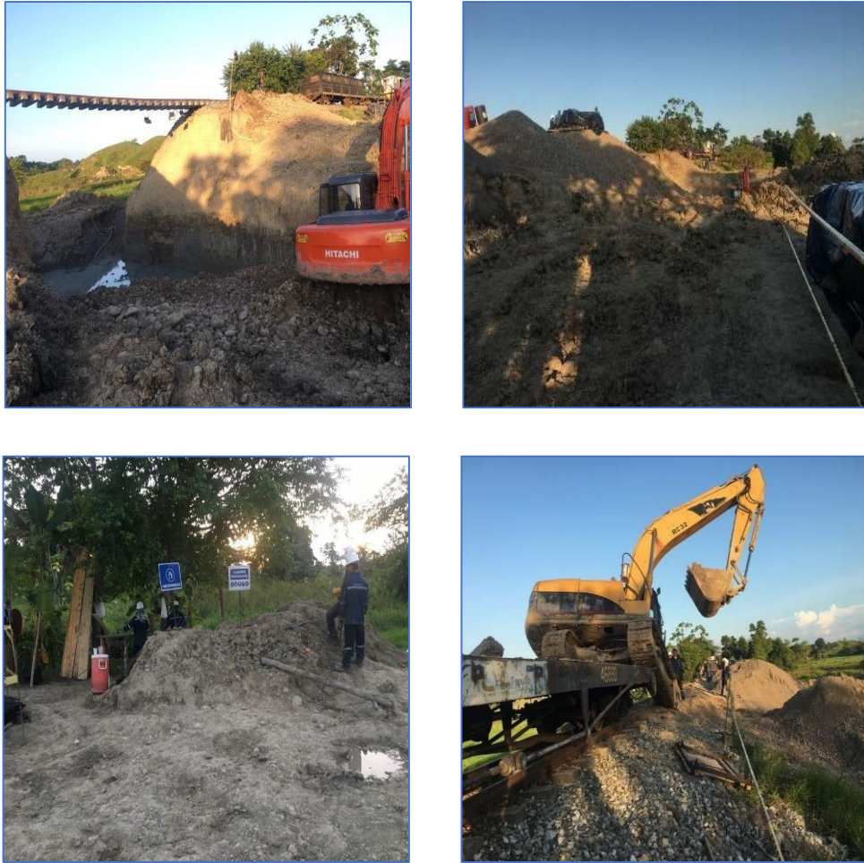
Figura 10. Inicio de obra- Rehabilitación del punto crítico PK 358+100
