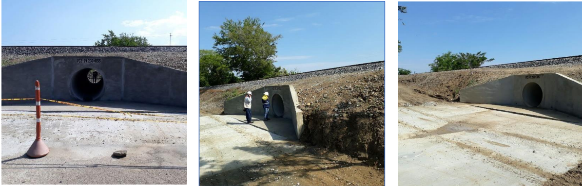
Figura 11. Entrega de Obra - Punto crítico PK 233+568
