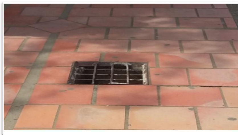
IMAGEN 15: Cajas eléctricas en mal estado Fuente: Soporte fotográfico del autor
