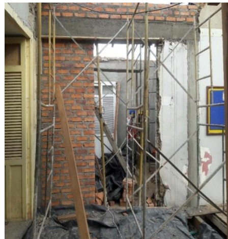
CONSTRUCCION DE VIGA AEREA
