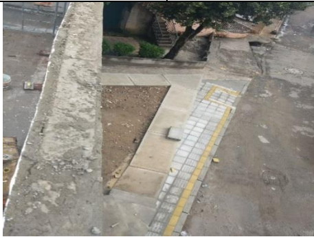
Anden entrada a salón comunal
