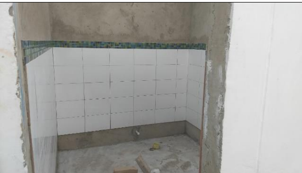
Enchape de baños
