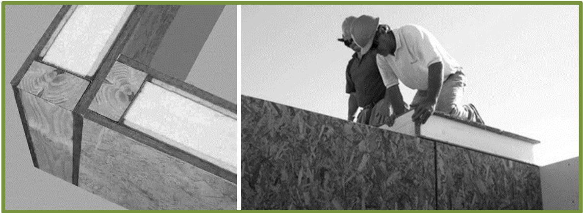
figura 7 Sistema constructivo SIP
