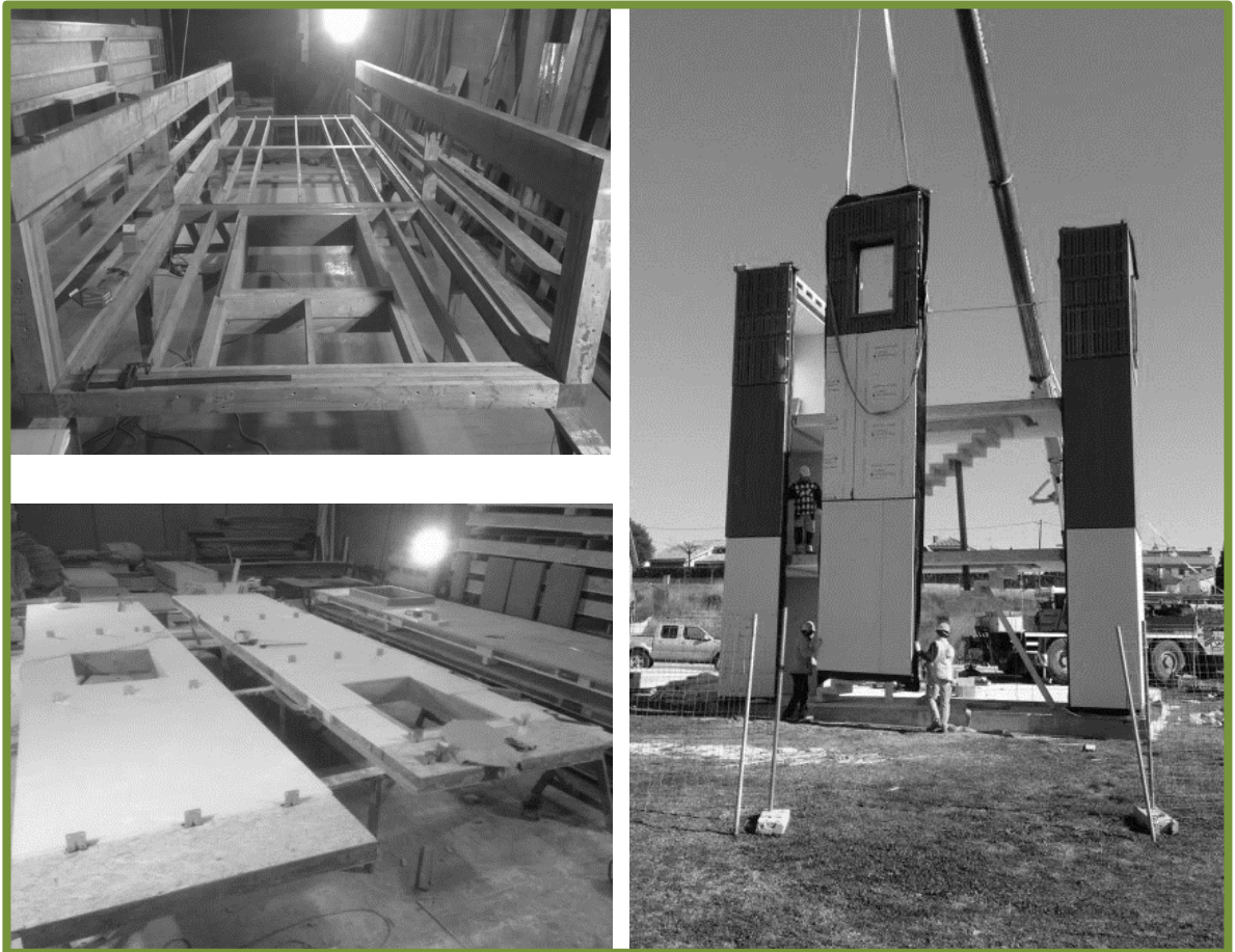
Figura 4 (Sistema constructivo modular CA2D)
