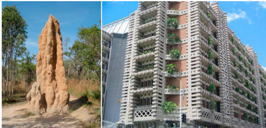
Figura 4: Mick Pearce -centro Eastgate en Harare, Zimbabue. Como referente, la forma en que los insectos utilizan recursos para crear montículos ventilados, infiltrándolos con agujeros en la superficie y como característica destacable la "ventilación pasiva". Los edificios utilizan energías renovables del ambiente que los rodea en lugar de aire acondicionado y sistemas de calefacción. (La Nación, 2015)
