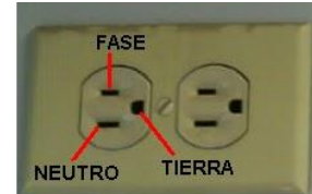
Ilustración 34. Toma puesta a tierra
