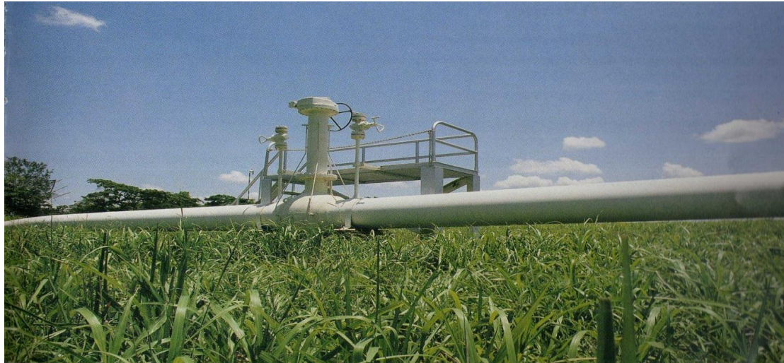
Figura 13. Tramo de Oleoducto en Colombia.
