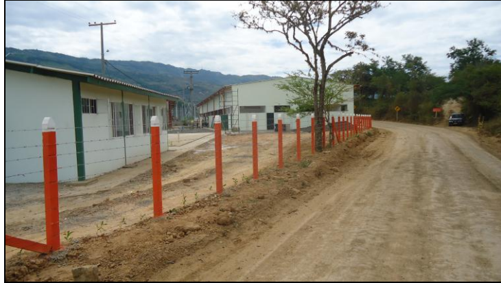
Fotografía No. 4. Panorámica Campamento Guaduro Fuente: Consorcio Vial Helios
