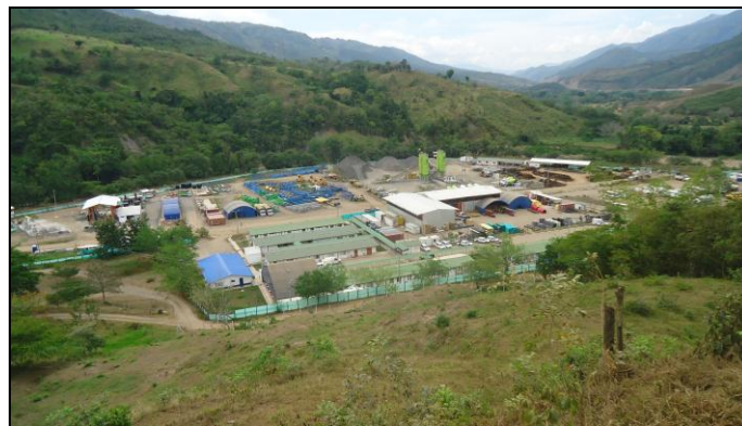
Fotografía No. 3. Panorámica Campamento Guaduro Fuente: Consorcio Vial Helios
