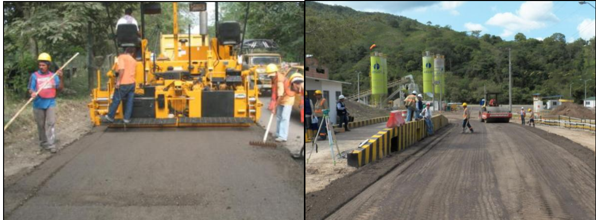
Fotografías No. 13 - 14. Extendida Finisher y Compactación
