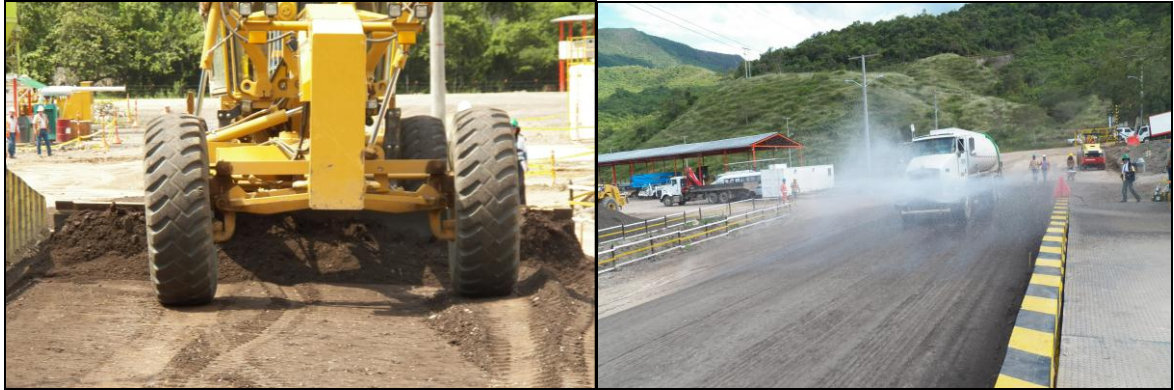
Fotografías No. 11 - 12. Extendida Motoniveladora y Humectación Fuente: Consorcio Vial Helios
