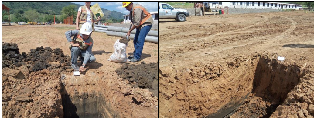
Fotografías No. 32 - 33. Exploración del Subsuelo Fuente: Consorcio Vial Helios – Los Autores
