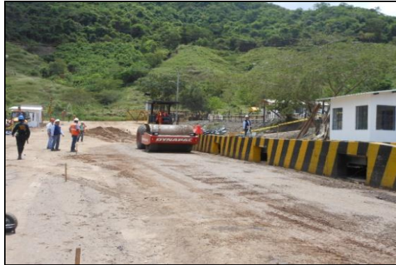
Fotografía No. 39. Proceso de Vibrocompactación Fuente: Consorcio Vial Helios – Los Autores
