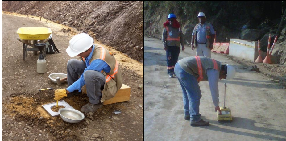
Fotografías No. 15 - 16. Toma Densidades Cono y Arena - Densímetro Fuente: Consorcio Vial Helios
