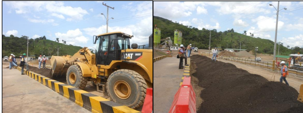
Fotografías No. 41 - 42. Proceso Instalación ASFALTITA Fuente: Consorcio Vial Helios – Los Autores
