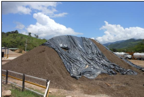
Fotografía No. 40. Acopio Resguardado ASFALTITA Fuente: Consorcio Vial Helios – Los Autores
