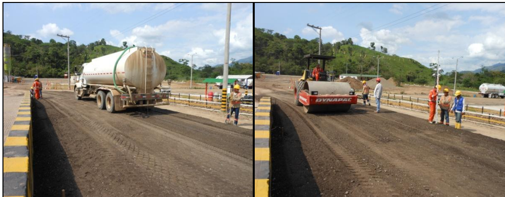
Fotografías No. 43 a 46. Proceso Constructivo ASFALTITA Fuente: Consorcio Vial Helios – Los Autores
