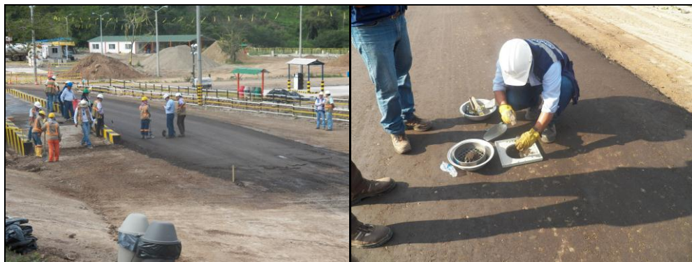
Fotografías No. 47 - 48. Proceso Constructivo Fuente: Consorcio Vial Helios – Los Autores
