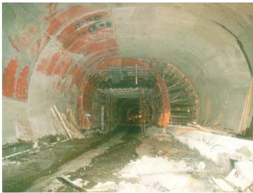
Túnel del Boquerón - 1998 Revestimiento en concreto convencional
