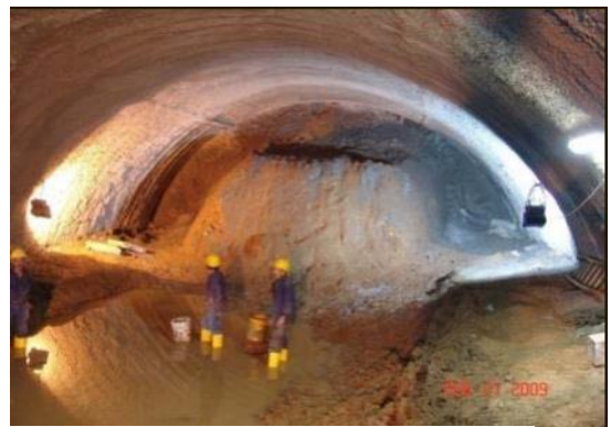
Túnel de Dos quebradas – 2009 Revestimiento en concreto lanzado
