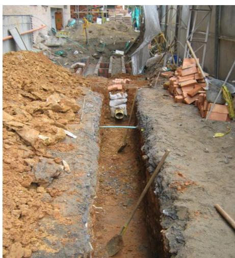
Foto No. 25 Red Interna de Alcantarillado
