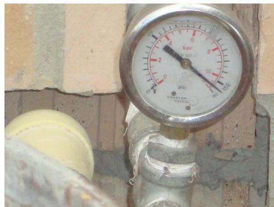
**Foto No 9 Manómetro de Ensayo de Prueba Hidráulica**
