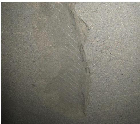
**Foto No. 14 Instalación de malla para friso**
