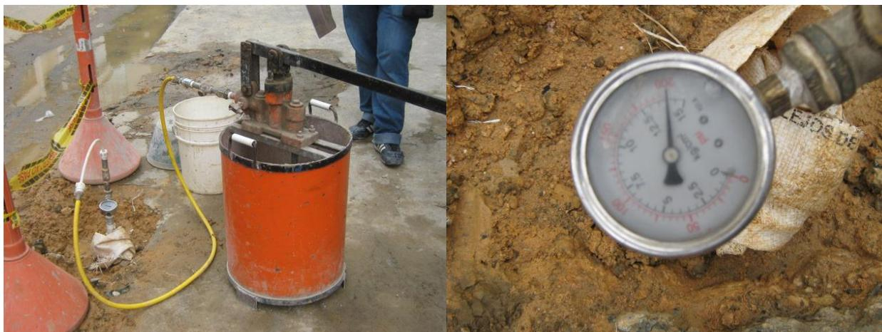
Foto No. 23 Prueba Hidráulica de la Red externa de acueducto
