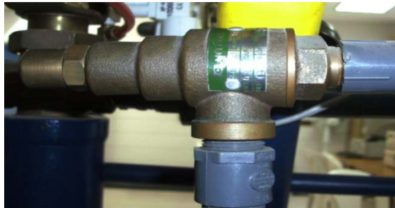
Figura 81. Válvula de Alivio de Agua sin Palanca en el Módulo de Nivel [11]
