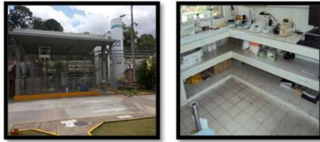
a- Zona de tanques b- Laboratorio
