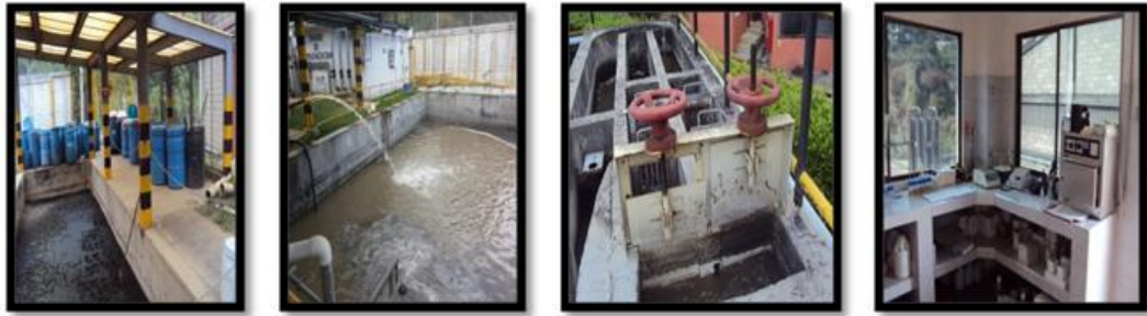
a- Lodos b- Piscina c- T. Homogenización d-Laboratorio
