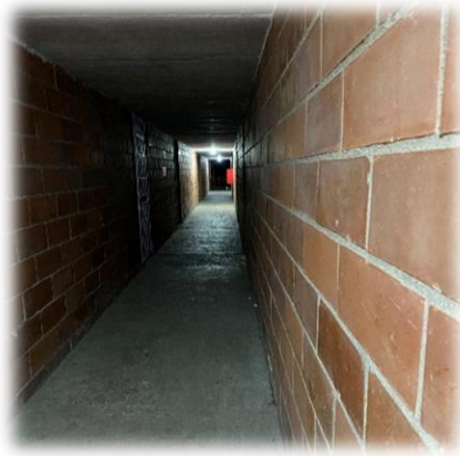
Estado de limpieza y aseo en zonas comunes 2021 Fuente Propia
